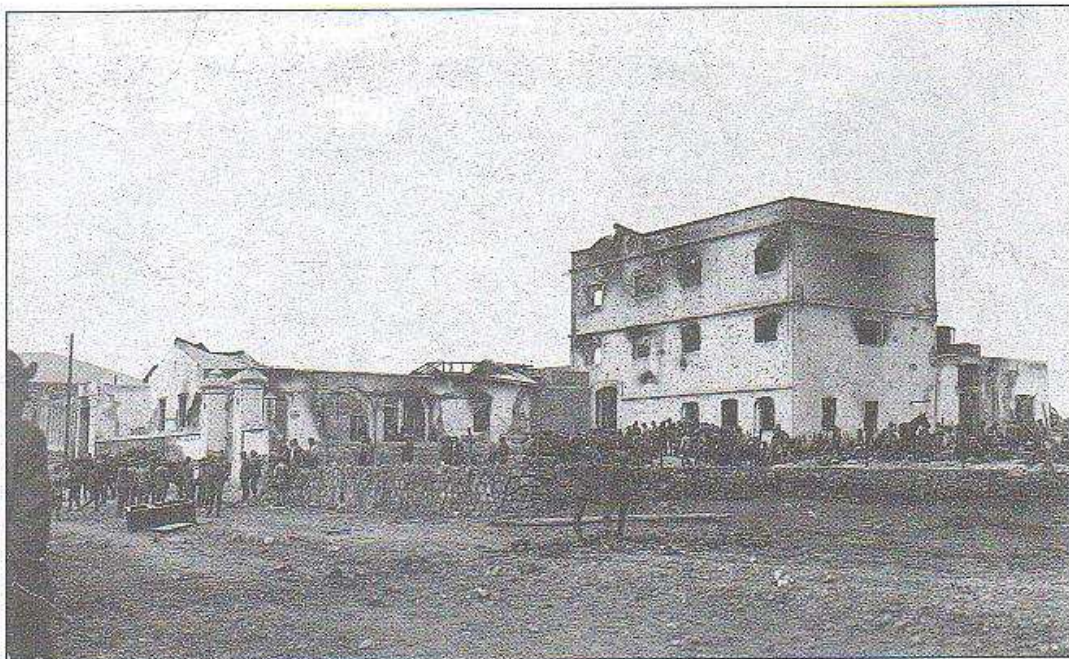
Vista de la derruida «fábrica de harinas», en Nador, donde se hicieron fuertes los guardias civiles que mandaba el teniente Fresno, tras la reconquista de la población (17 de septiembre de 1921). Fotografía de autor desconocido. Colección documental del autor.
